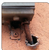
Bescherming ingang geribbelde leiding ...
