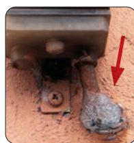
Bescherming ingang geribbelde leiding ...
