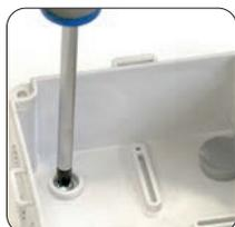
Fixar a caixa à parede e tapar os parafusos com os tapa-parafusos.
